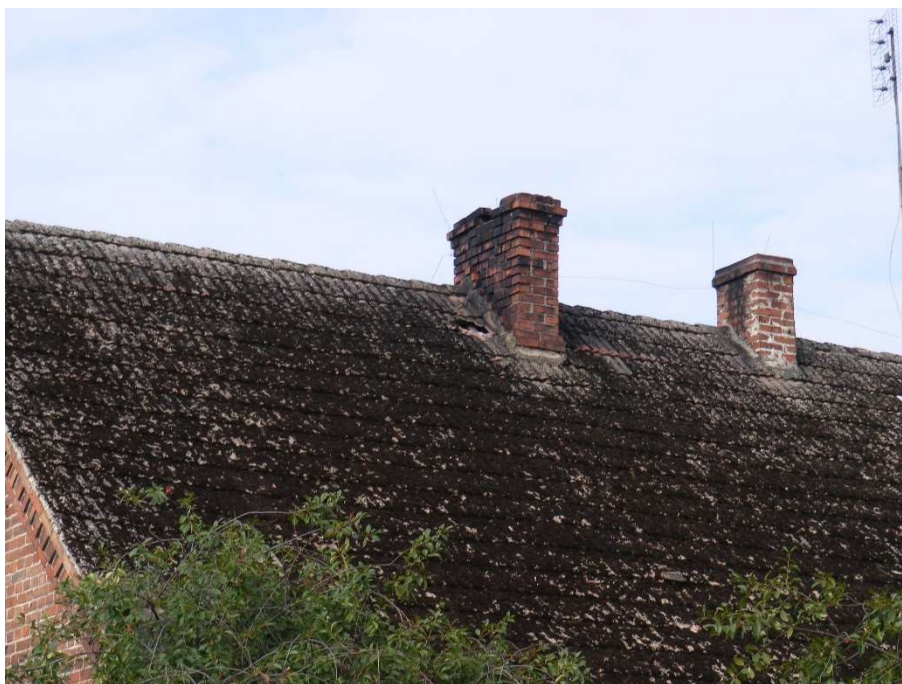
Strona północna dachu
