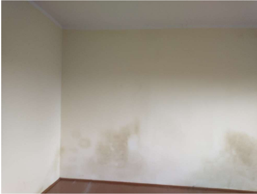
Wnętrze lokalu 14/2 – nieużytkowane
