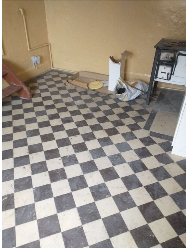
Wnętrze lokalu 14/2 – nieużytkowane
