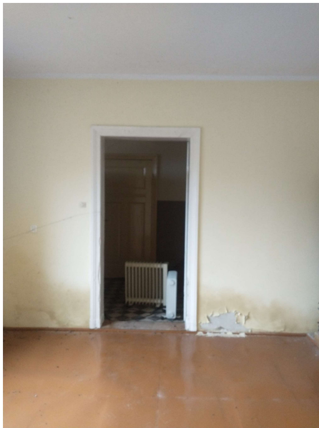
Wnętrze lokalu 14/2 - nieużytkowane
