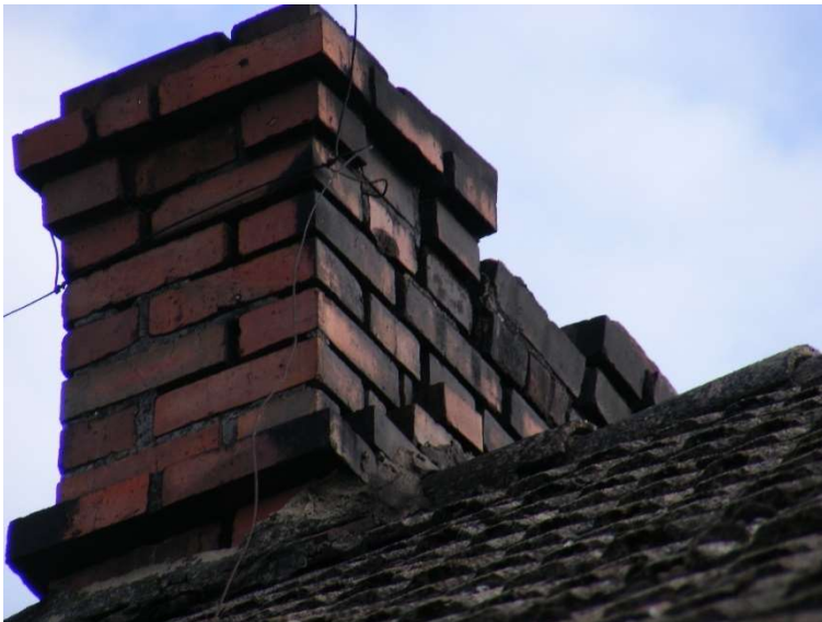
Istniejący stan komina
