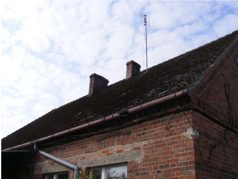
Strona północna budynku
