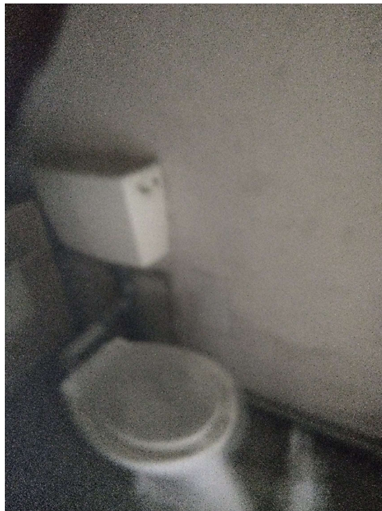
Wnętrze lokalu 14/2 - nieużytkowane
