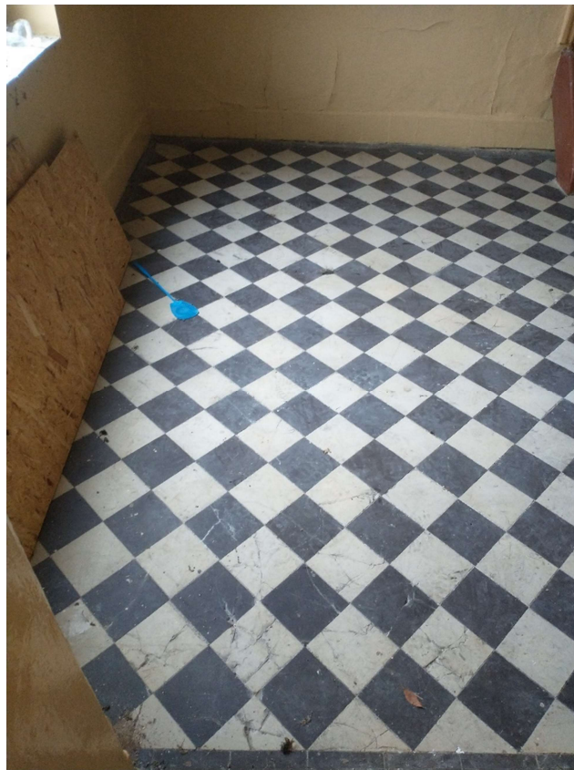
Wnętrze lokalu 14/2 – nieużytkowane
