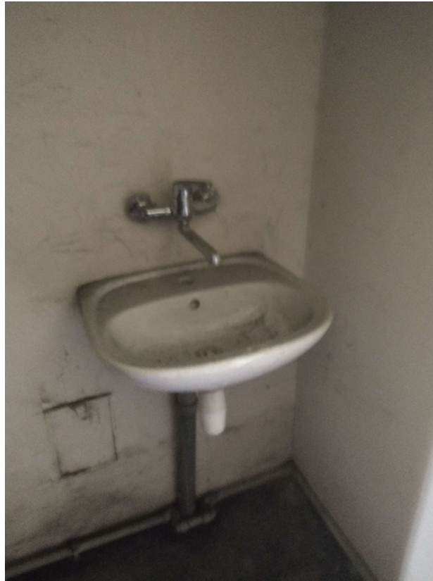
Wnętrze lokalu 14/2 - nieużytkowane
