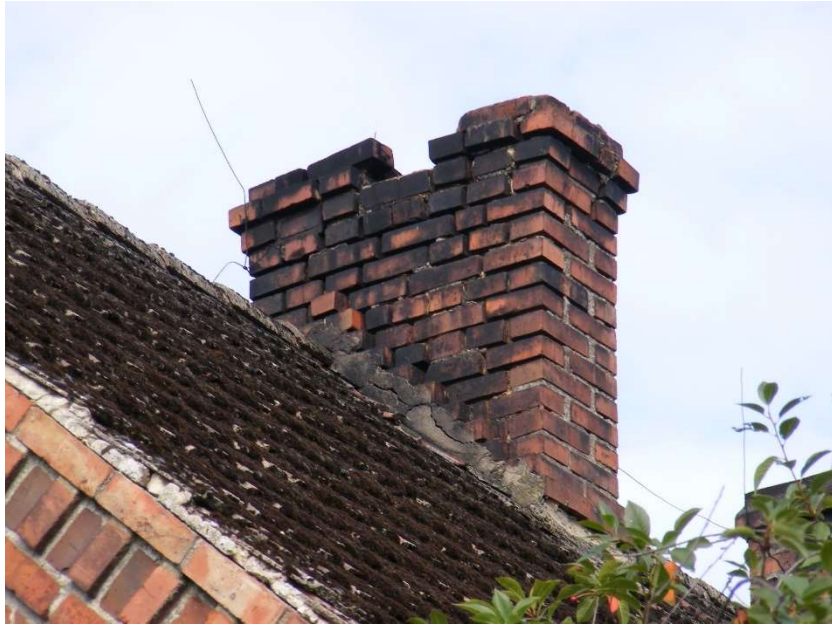
Stan istniejący komina
