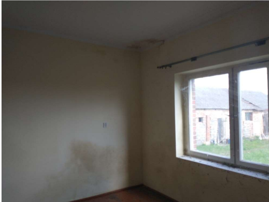
Wnętrze lokalu 14/2 - nieużytkowane
